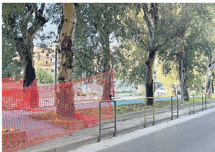
A pag. 23 Il cantiere della ciclabile di viale Beneduce
