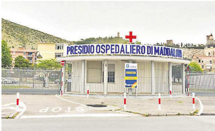
LA STRUTTURA Completati i lavori del blocco centrale
